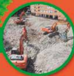
DERRIBOS Y DEMOLICIONES
